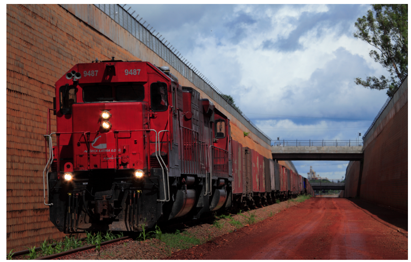
Rebaixamento Linha Férrea Maringá | Maringá - PR, 2013
