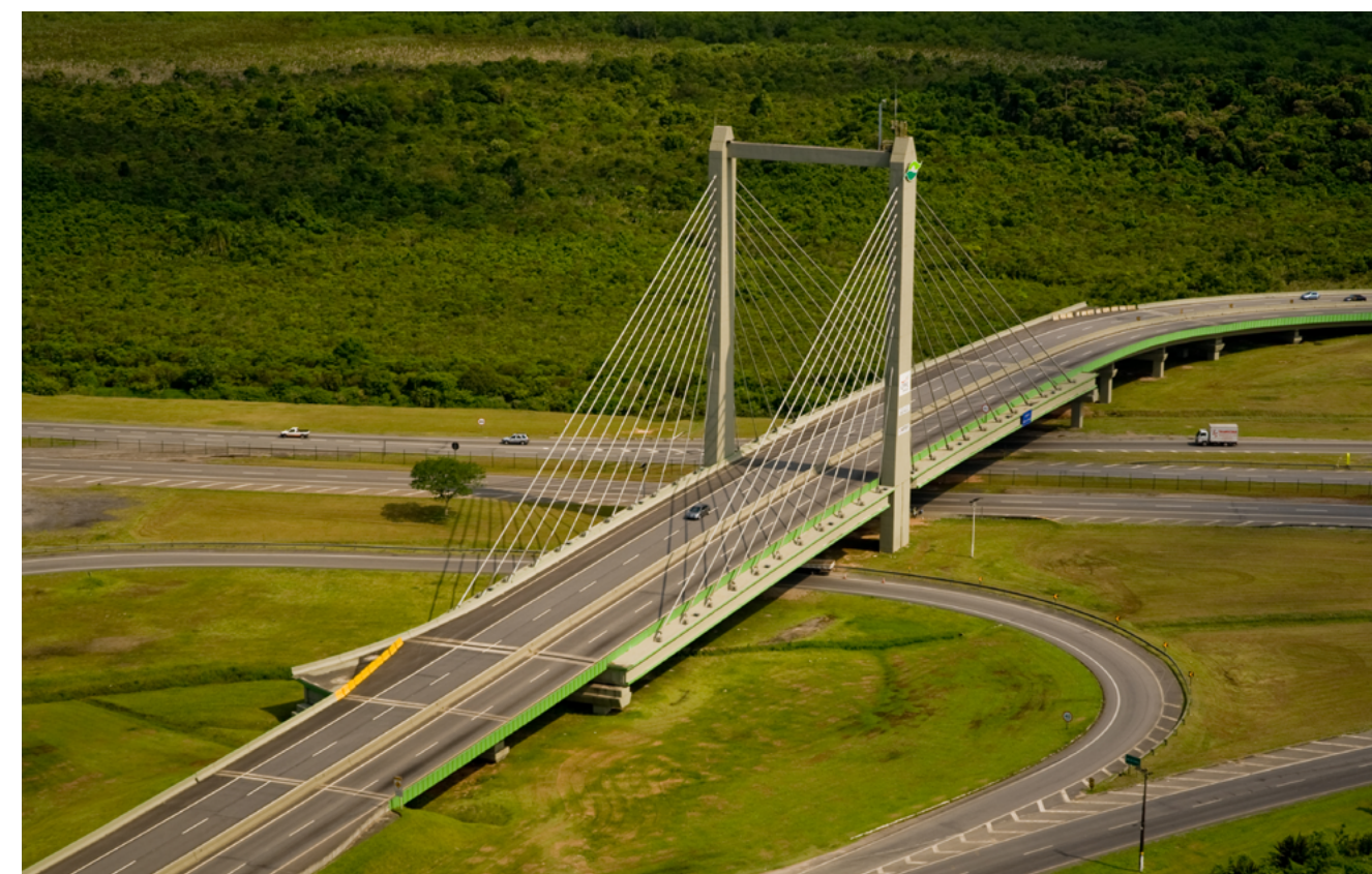
Viaduto Estaiado sobre a Rodovia Imigrantes | São Bernardo do Campo - SP, 2002
