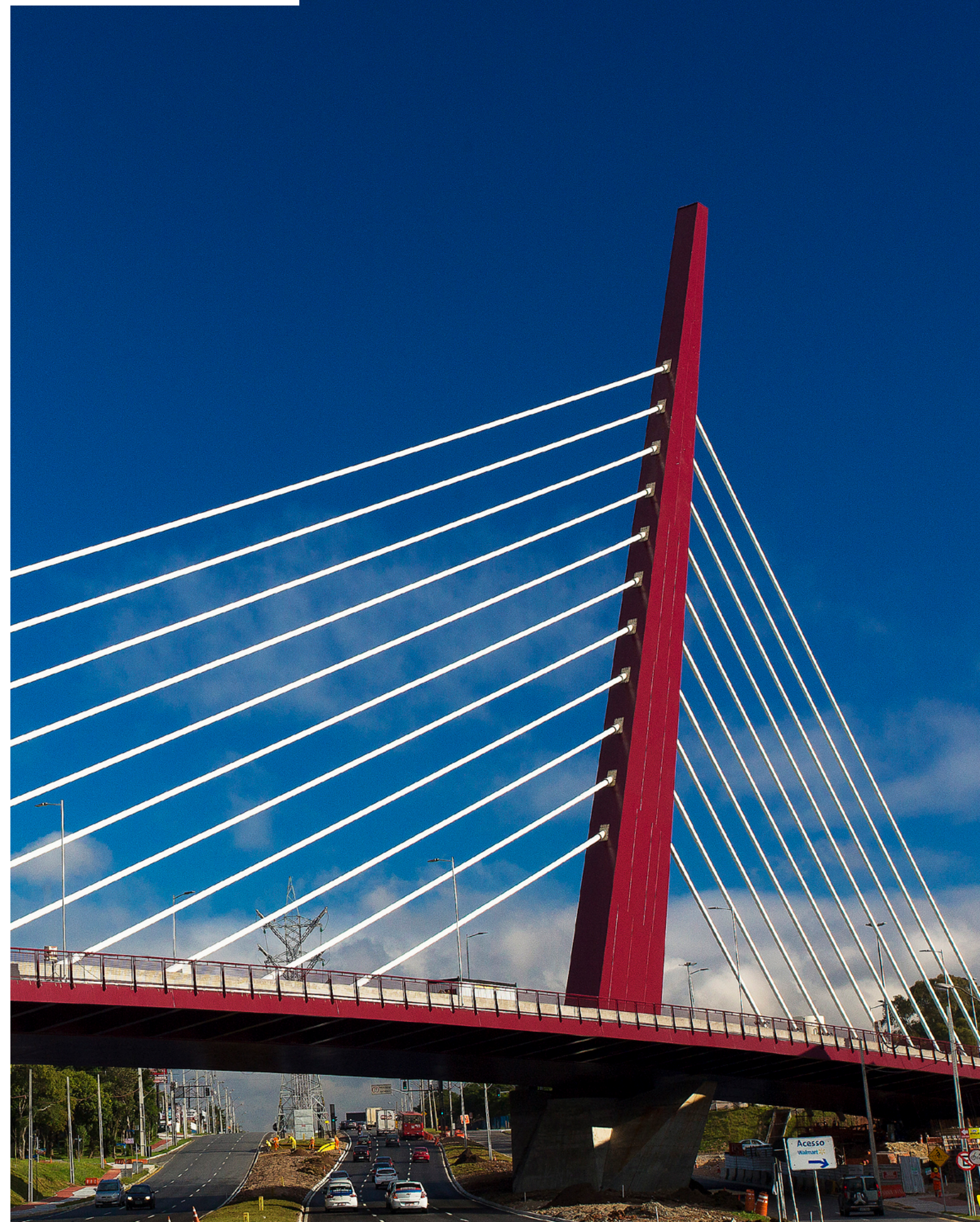
Viaduto Estaiado Curitiba - PR, 2014
