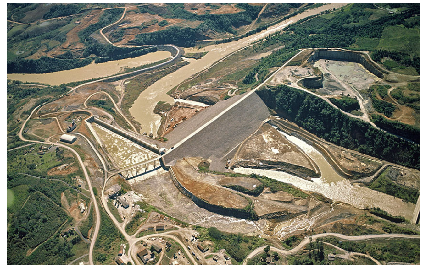
Barragem Norte | Ibirama - SC, 1993
