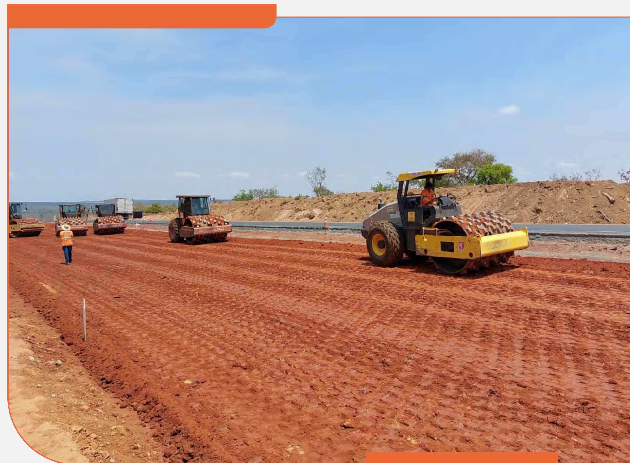
Obras na ICCR 135, em Curvelo (MG)
