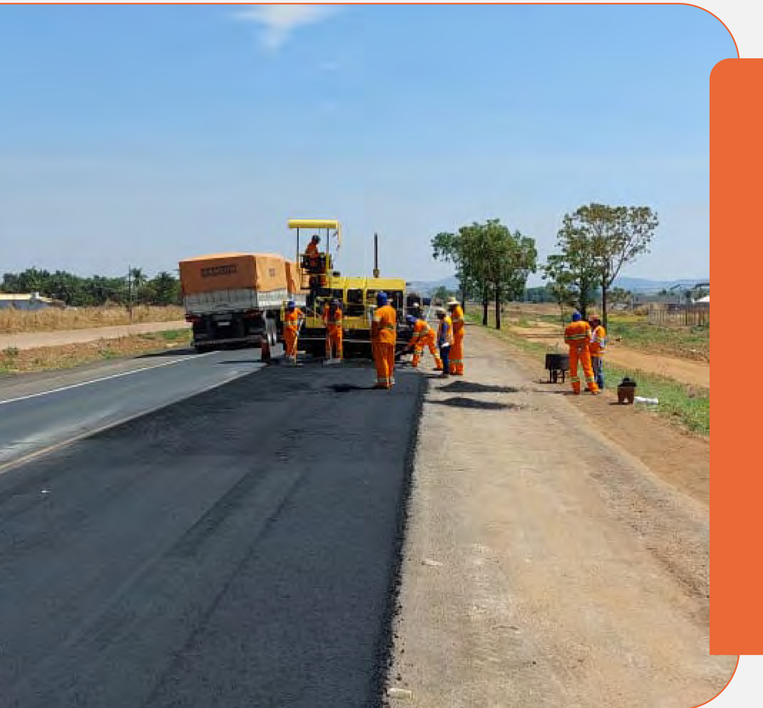
Obras na ICCR 153, em Uruaçu (GO)
